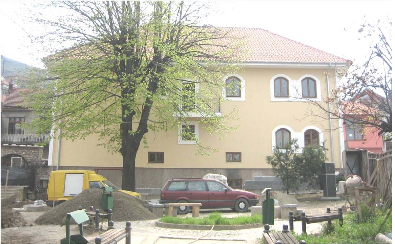
Северна фасада ново-обновљеног Владичанског двора у Призрену, април 2008.
