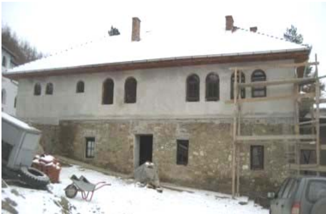
Изглед конака након завршетка грубих радова у зиму 2007., западна фасада
