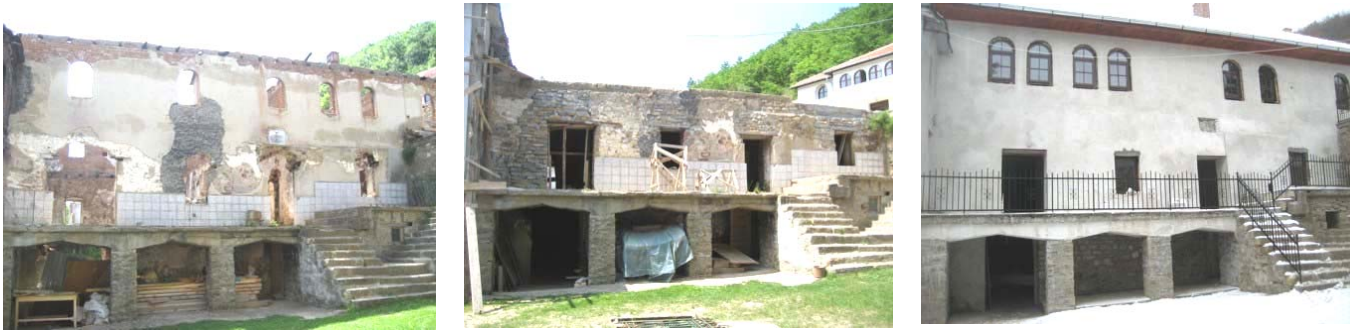
Фазе реконструкције централног конака у манастиру Девич (почетно стање, консолидација, радови на обнови – зима 2007) Скице доле: пресек новог конака и пресек основе другог спрата
